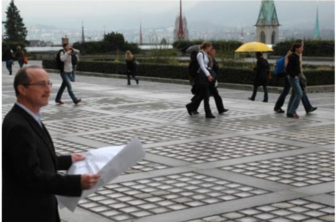
Weil es nicht nur bis auf den Boden tropft: Die Polyterrasse wird unter der Bauleitung von Peter Hoch (links) saniert.
